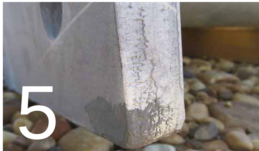
Photo 5 : Exemple de matériel galvanisé réparé avec de la pâte de zinc.
